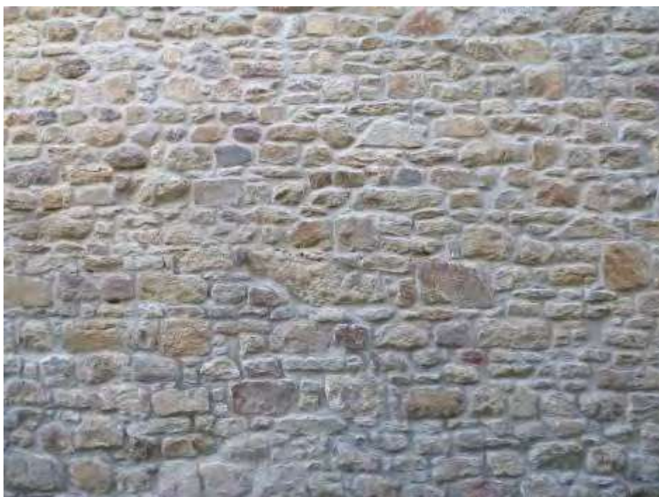
Mur de moellons de pierre destinés à être enduit
