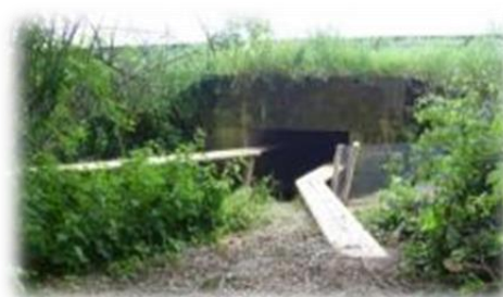
Figure 11 : Passage à faune de type encorbellement, source CCVIA
