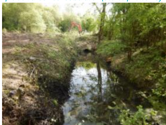
Remise à ciel ouvert : avant
