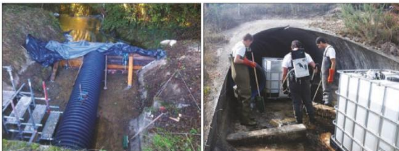
Figure 14 : A gauche : dérivation par busage et batardeaux ; à droite : pêche électrique préalable réalisée par la FDPMA (source Vinci Autoroutes)
