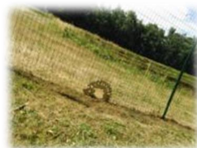
Figure 29 (ci-dessus) : Engrillagement permettant le passage de la petite faune, source CCVIA
