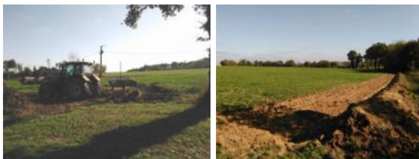
Figure 1 : création d'un talus (source : CCVIA)
