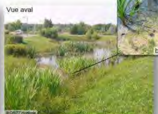
Illustration 3 – Aménagement de gestion des eaux de voiries dans un cas de forte fréquentation. Cet ouvrage infiltre, stocke et collecte les eaux de ruissellement. La forme et les dimensions évoluent de la noue au bassin. A son extrémité aval, les pentes favorisent un stockage important. Le fond du bassin est étanche pour éviter une infiltration vers la nappe* qui est proche. La végétation est différenciée : graminées en périphérie, haie d'arbustes en bordure et cortège d'hygrophiles dans la partie la plus humide. La photo de détail (b) montre la contamination de la vase. Elle est extraite manuellement lors des périodes d'étiage*. En fonction des quantités à gérer, elle est exportée comme un déchet spécifique ou épandue sur les espaces verts environnants pour être dégradé par minéralisation, tout en évitant qu'elle ne se redépose dans l'aménagement.
