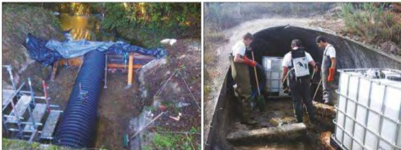
Figure 14 : A gauche : dérivation par busage et batardeaux ; à droite : pêche électrique préalable réalisée par la FDPMA (source Vinci Autoroutes)
