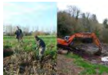
Figure 4 : Curage manuel et mécanique, source : Guide technique d'aménagement et de gestion des zones humides du Finistère (2013)
