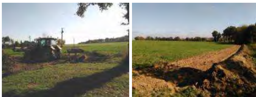
Figure 1 : création d'un talus (source : CCVIA)
