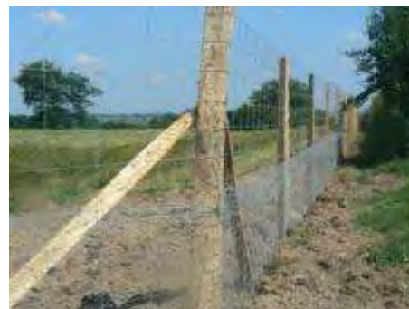
Figure 7 : clôture d'un enclos de chasse
