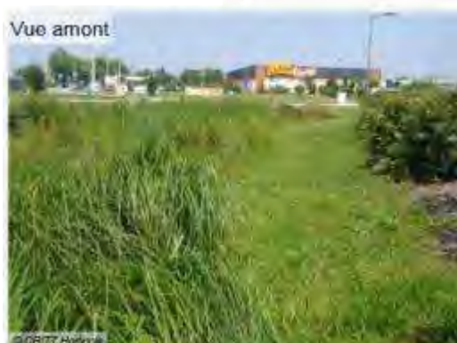
Illustration 3 – Aménagement de gestion des eaux de voiries dans un cas de forte fréquentation. Cet ouvrage infiltre, stocke et collecte les eaux de ruissellement. La forme et les dimensions évoluent de la noue au bassin. A son extrémité aval, les pentes favorisent un stockage important. Le fond du bassin est étanche pour éviter une infiltration vers la nappe* qui est proche. La végétation est différenciée : graminées en périphérie, haie d'arbustes en bordure et cortège d'hygrophiles dans la partie la plus humide. La photo de détail (b) montre la contamination de la vase. Elle est extraite manuellement lors des périodes d'étiage*. En fonction des quantités à gérer, elle est exportée comme un déchet spécifique ou épandue sur les espaces verts environnants pour être dégradé par minéralisation, tout en évitant qu'elle ne se redépose dans l'aménagement.
