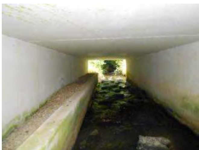
Banquette pour passage à loutre, avec aménagements pour ralentir le débit (source Biotope)
