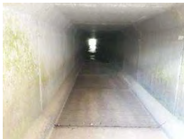
Intérieur de l'ouvrage actuel
