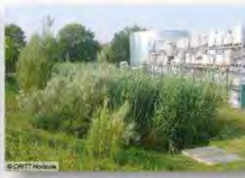
Illustration 2 – Hélophyte. Le centre de ce bassin d'infiltration est végétalisé par une roselière. Le mouvement des grandes tiges des roseaux (action du vent) ainsi que leur chevelu racinaire, créent des chemins d'infiltration préférentiels. L'activité biologique est également favorisée et entretient la porosité* du sol. Cet aménagement nécessite un entretien régulier.
