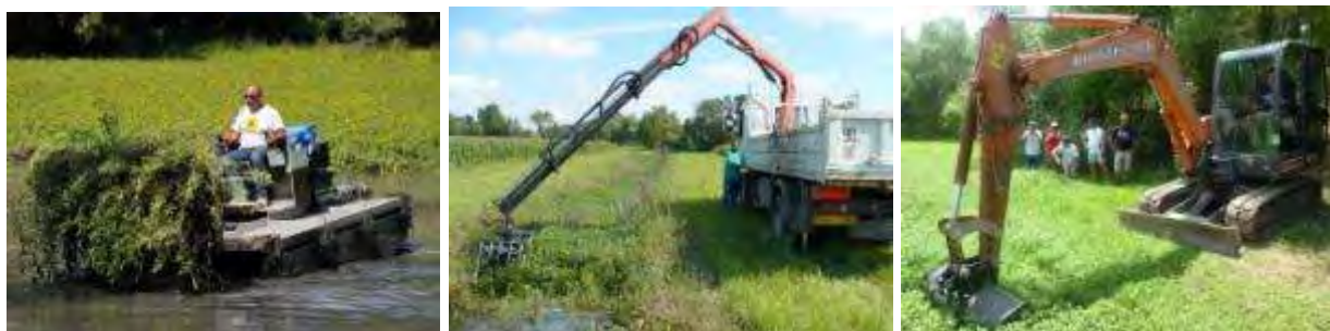
De gauche à droite : faucardage ( Energis Nautic Services), enlèvement à la griffe ( N. Pipet) et enlèvement au godet
