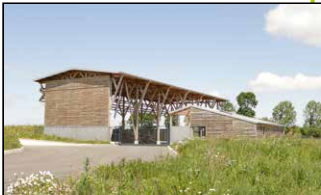
La plateforme biomasse
