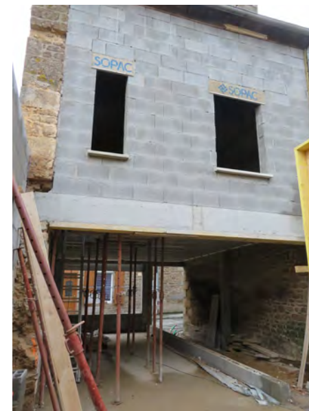
Opération de réhabilitation en centre bourg : Construction de 2 logements rue gramont à Sens de Bretagne
